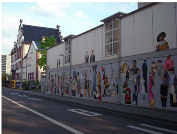
Blick auf die neue Fassade
