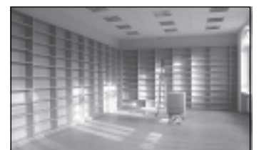
Blick in die gerade frisch gestrichene Bibliothek. Umbauand: Ende November 2003. Foto: Mathias
